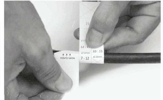
**8.4.2** Realize a preparação do cabo, deixando uma ponta livre a 200 cm da extremidade:
