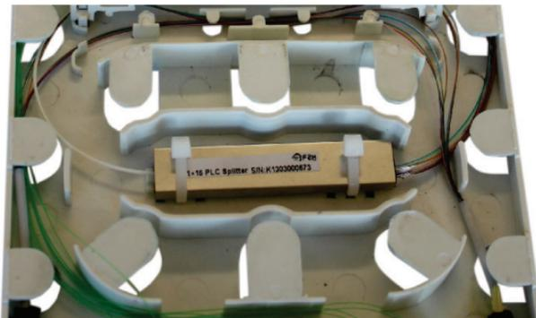
**6.2.4** Passagem das fibras na base das bandejas de fibra:
