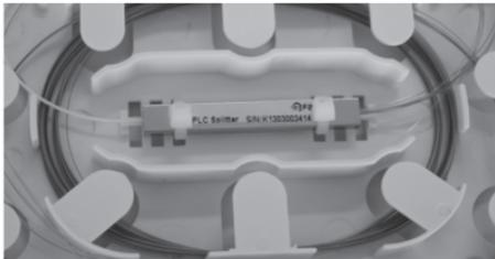
**8.2.4** Antes de iniciar as fusões, todas as fibras a serem emendadas devem ser organizadas nas bandejas para determinar o comprimento exato das sobras de fibras piloto. Este processo é muito importante, porque vai facilitar o acondicionamento das fibras depois de emendadas.
