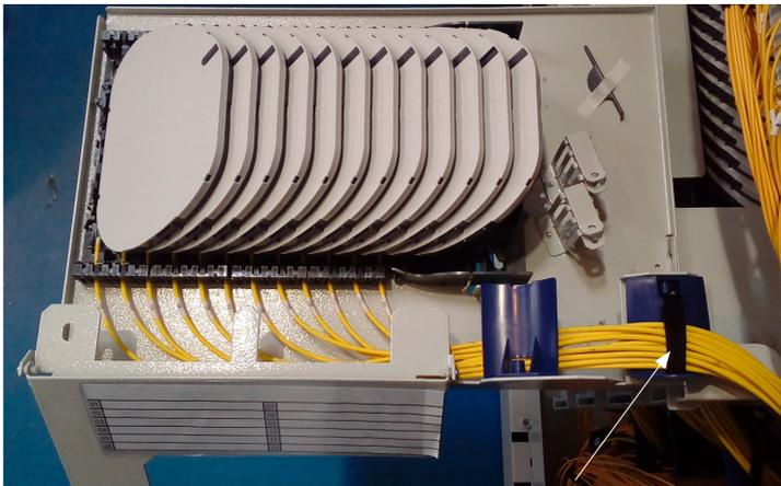
Fita de Velcro fixando os cabos de saída no Mandril
