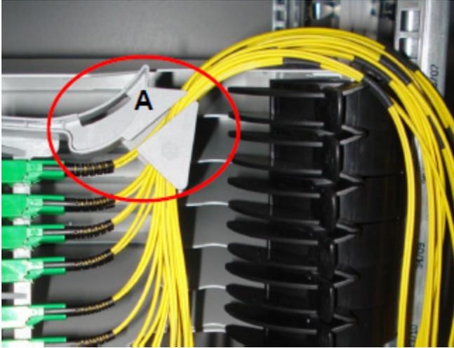
**Etapa 8.** Deslize o cassete FIBERTRAY para dentro da unidade mantendo o comprimento suficiente para os cordões e prenda todos os cabos com o elástico do mandril preto (A). Guie os cabos através da coluna do rack em direção ao mandril azul (B).
