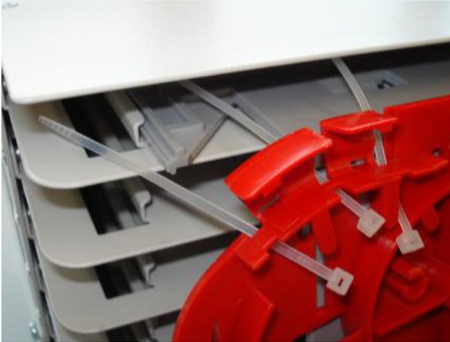
**Etapa 9.** Corte o tubo loose a 20 mm da extremidade do conduíte.
